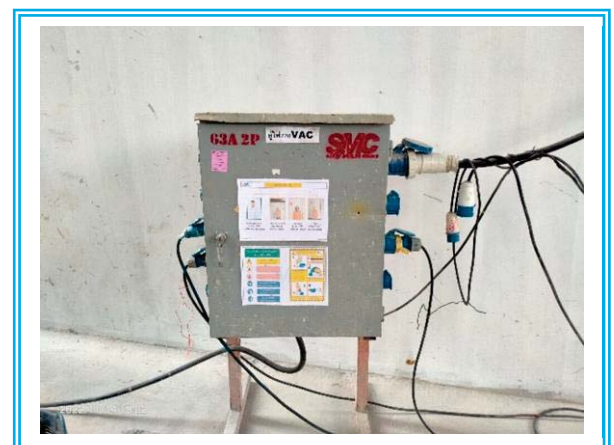
รูปที่ 3.1-35 แผงควบคุมไฟฟ้าและเครื่องตัดกระแสไฟฟ้า อัตโนมัติ
