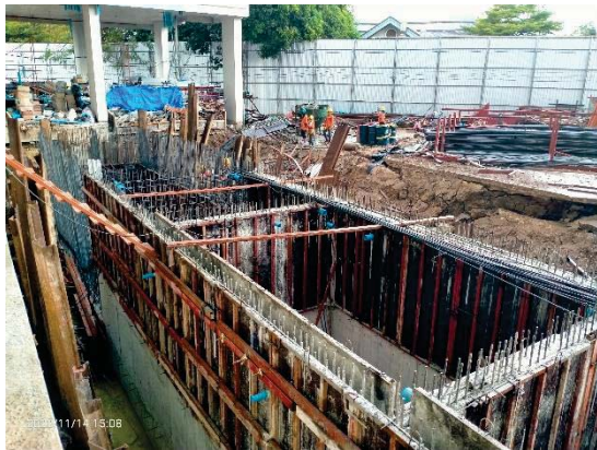
รูปที่ 3.1-15 ติดตั้ง Sheet Pile
