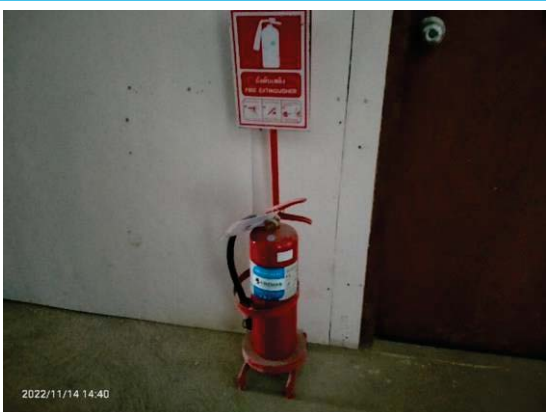
รูปที่ 3.1-29 ถังดับเพลิงชนิดมือถือ
