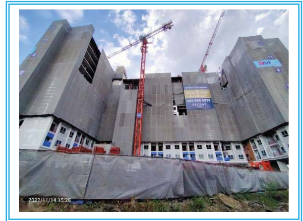
รูปที่ 3.1-57 ติดตั้ง Mesh Sheet
